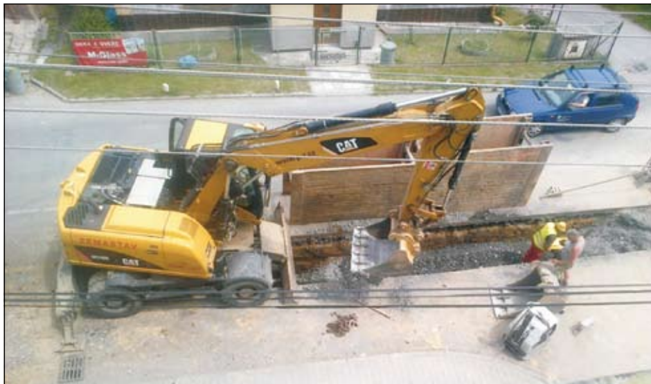
Pokládka potrubí splaškové kanalizace na ul. Markvartovická.
