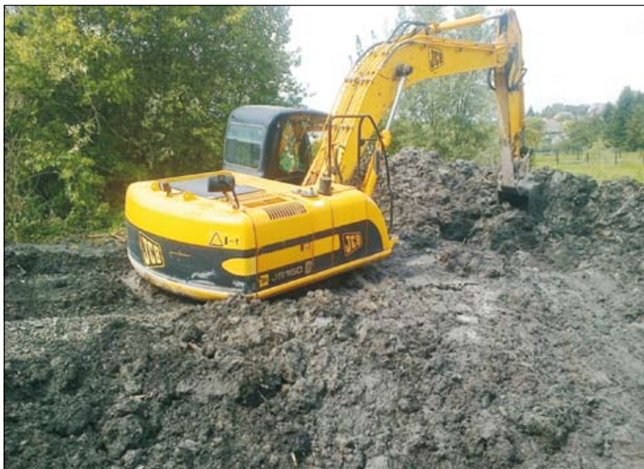
Na snímku je zřejmé, že zemní práce byly díky geologii podloží velkou výzvou i pro techniku.
