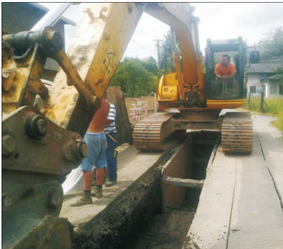
Pokládka potrubí splaškové kanalizace na ul. Na Návsi.
