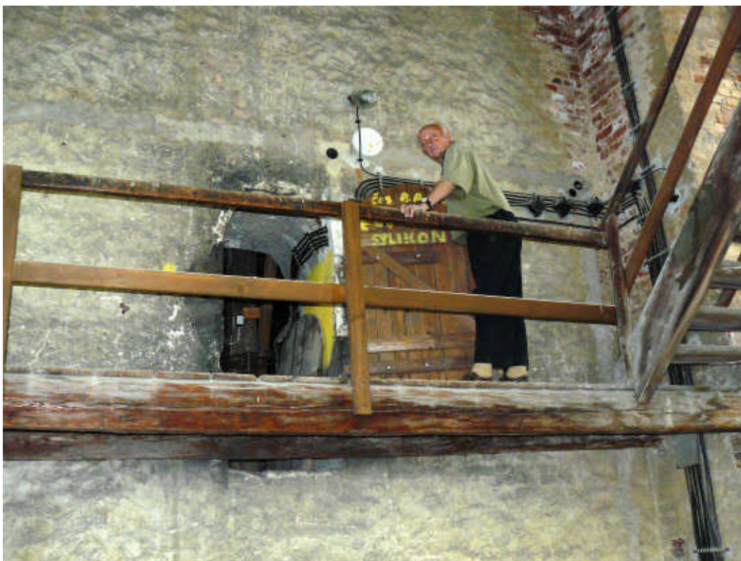
Dveře z věže na půdu nad hlavní lodí kostela
