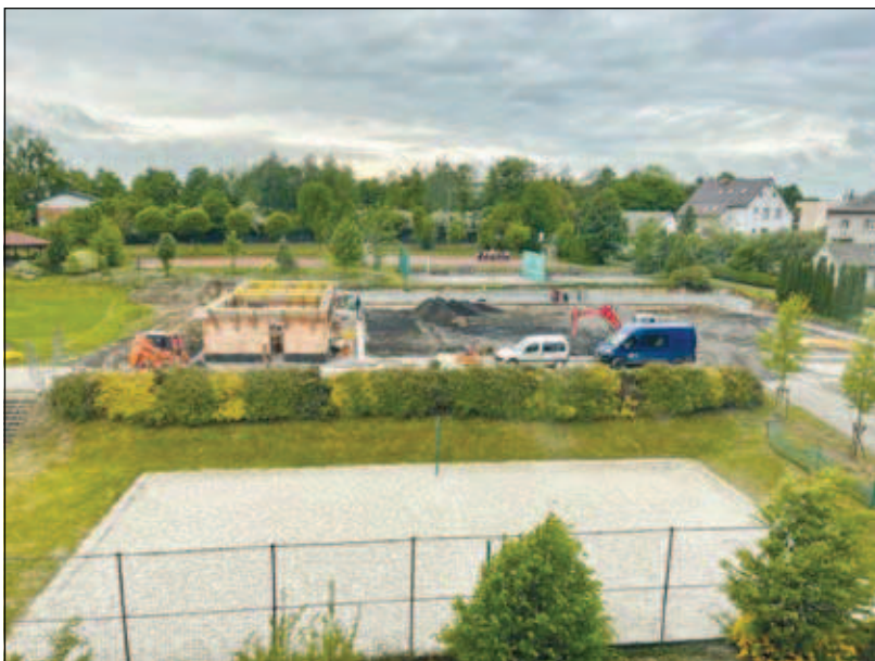
stavba nové nafukovací haly – květen 2021
