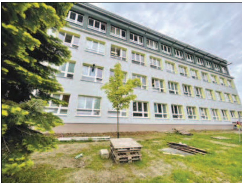
pohled na novou fasádu hlavní budovy – květen 2021
