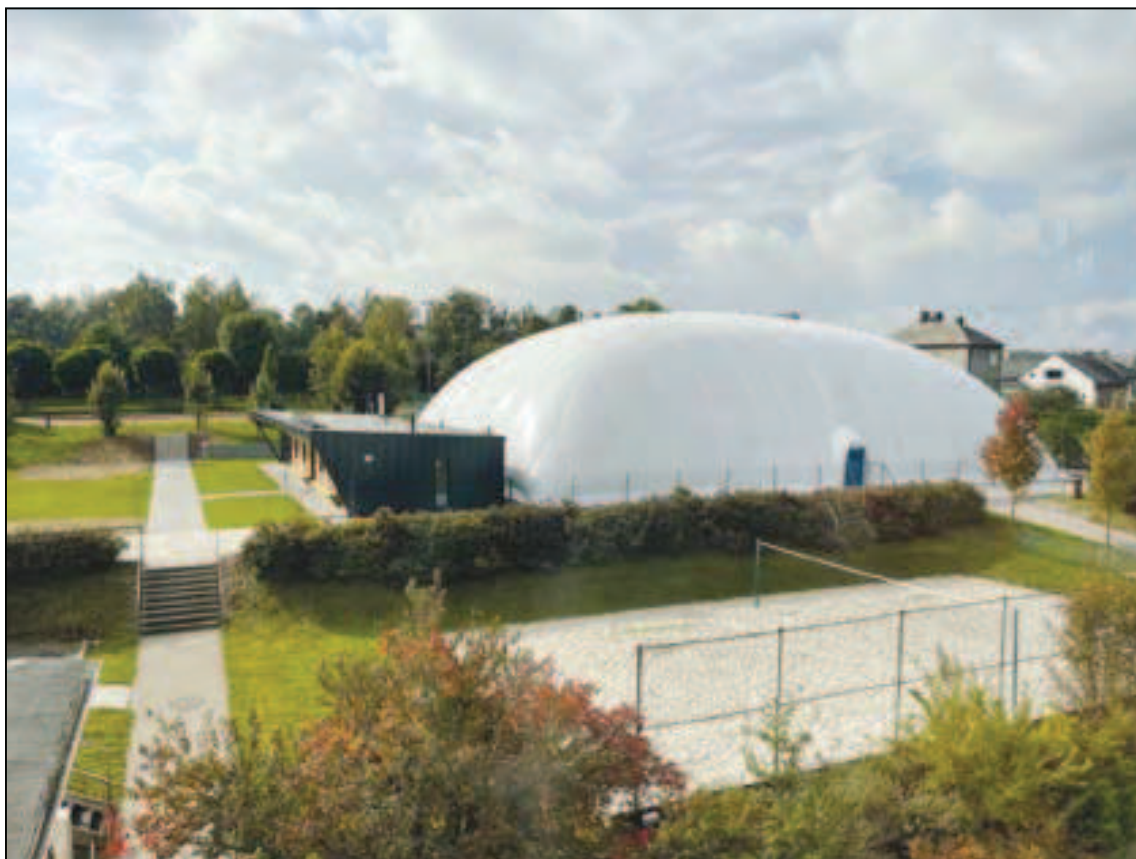
nafukovací hala a sociální zázemí
