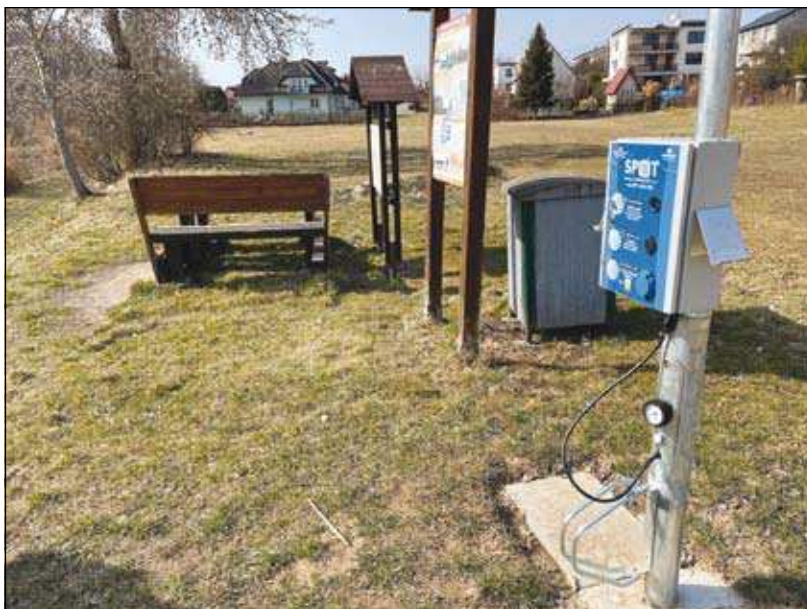
nabíjecí stanice pro elektrokola včetně pumpy
