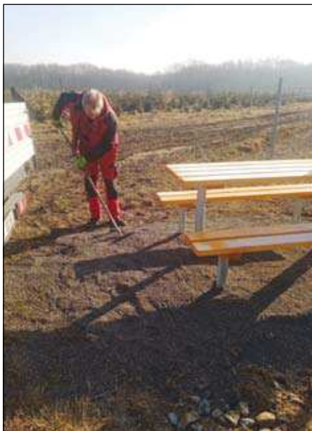
dokončovací práce na lavičkách v blízkosti Jurčkovy kapličky
