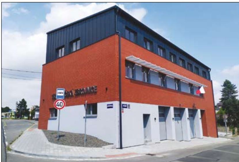
zrekonstruovaná budova hasičské zbrojnice
