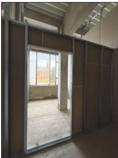
foto ze stavby centra služeb z 12. března
