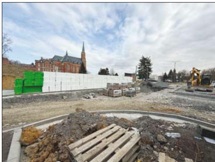
foto ze stavby centra služeb z 12. března
