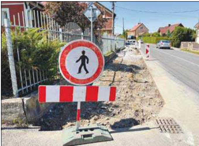
oprava chodníku na ulici Markvartovická od OÚ směrem ke kostelu
