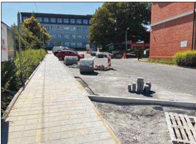
oprava chodníku u základní školy
