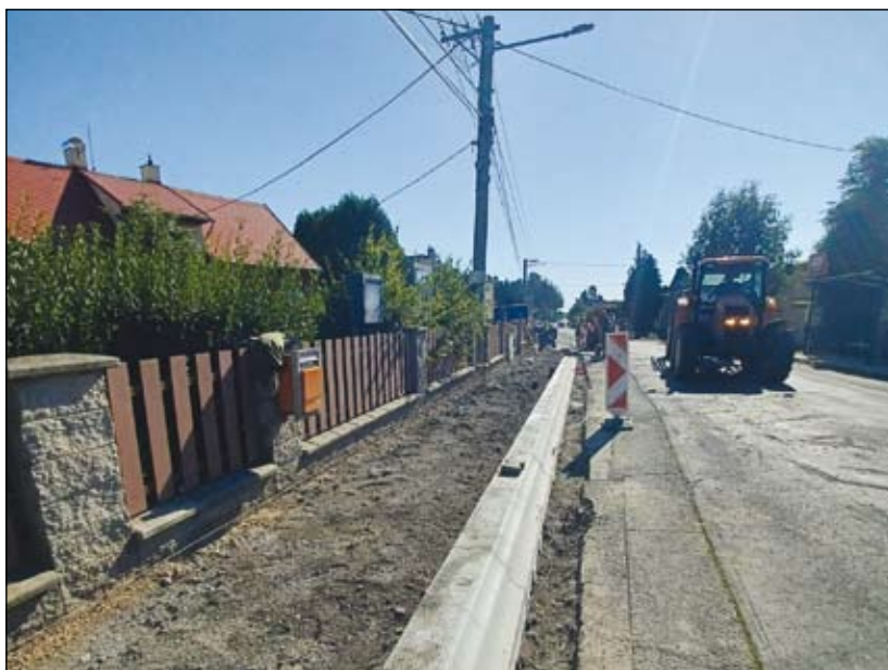
oprava chodníku na Vrablovci – foto z 14. srpna
