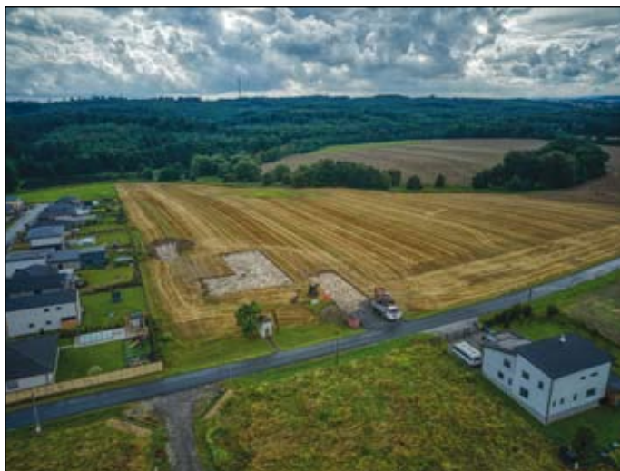
výstavba nové MŠ Rybníky u ulice Vrablovecká
