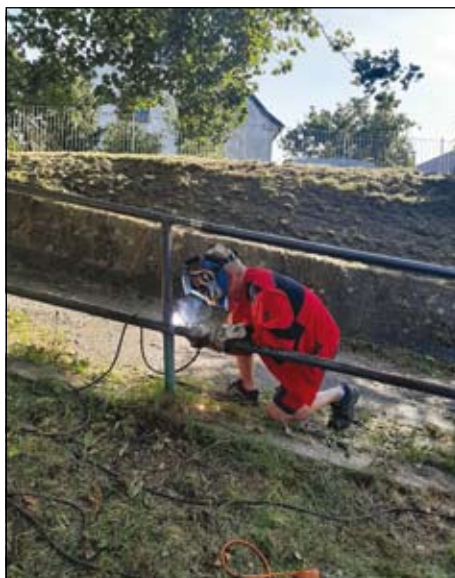
svařování trubek na zábradlí
