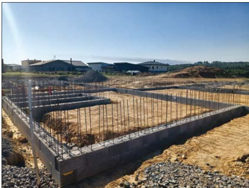
výstavba nové mateřské školy – foto z 14. srpna
