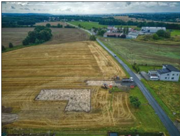
výstavba nové MŠ Rybníky u ulice Vrablovecká – pohled k HP Trendu
