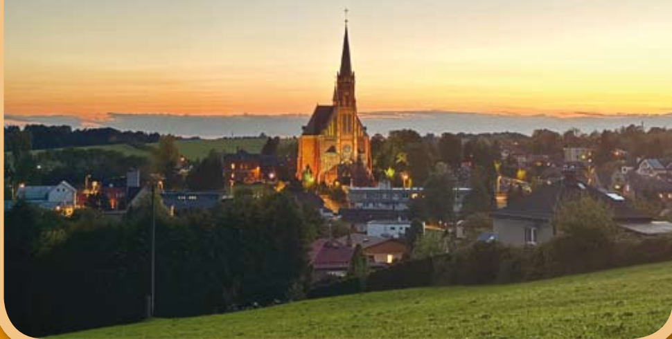
pohled na kostel sv. Mikuláše – P.K.
