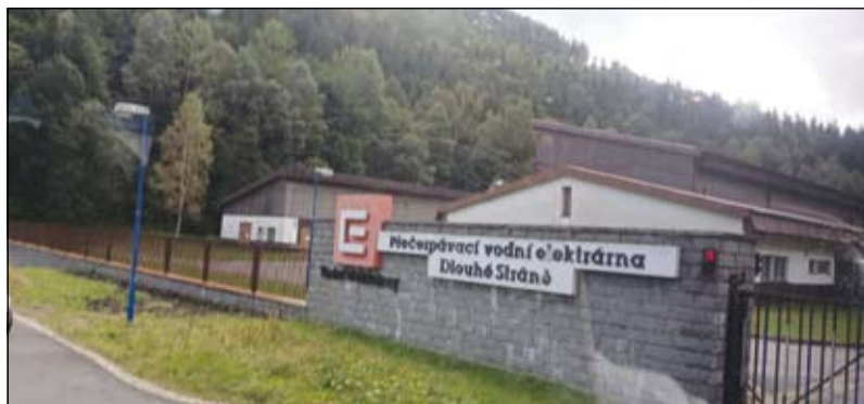
přecherčpávací vodní elektrárna Dlouhé Stráně
