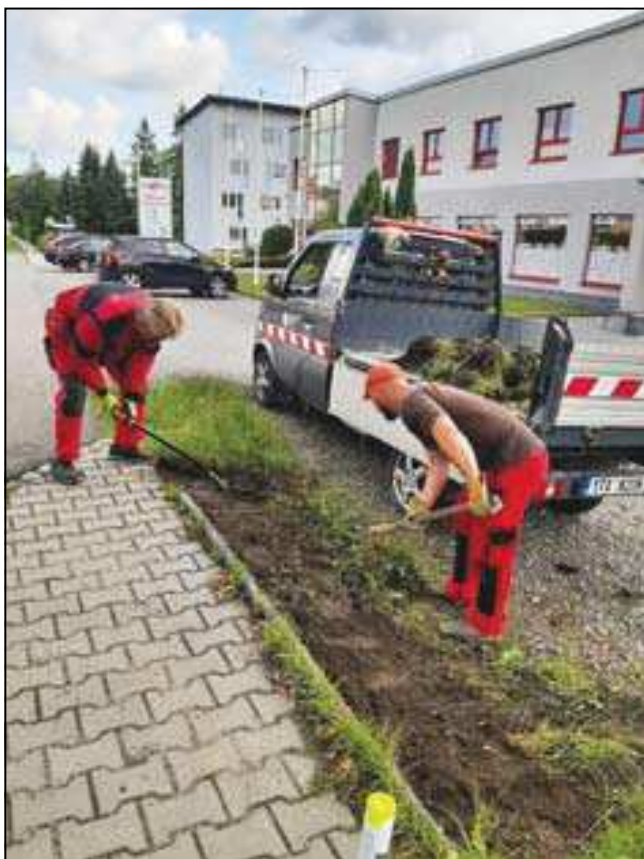
příprava na zhotovení betonových základů
