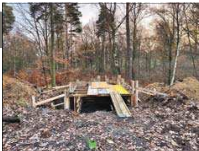
stav v listopadu 2022 – základy kapličky
