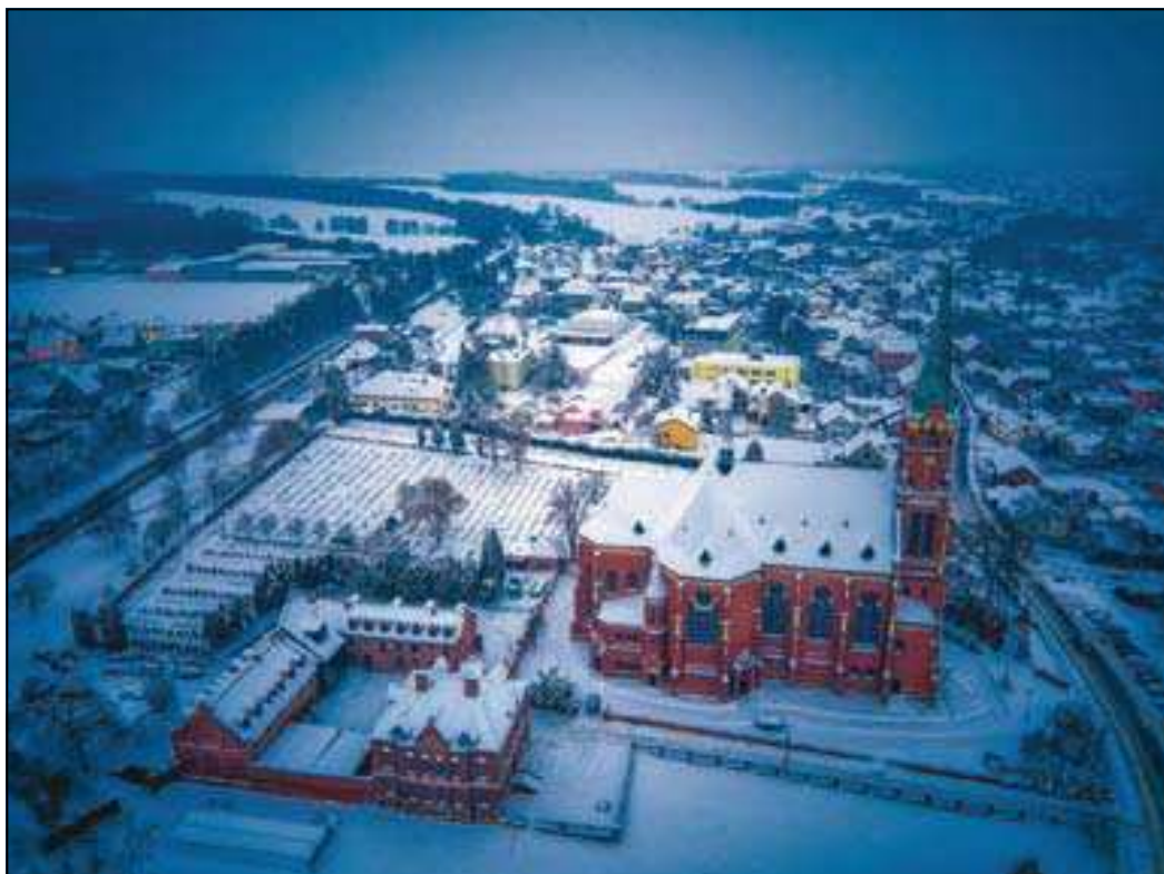
pohled z dronu – kostel, za ním ul. Nádražní
