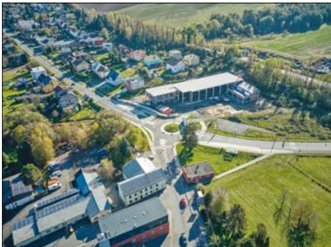
stavba Centra služeb – znovu se pokračuje – foto 19. října
