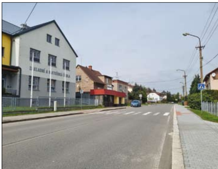
opravený chodník naproti dolní budovy školy
