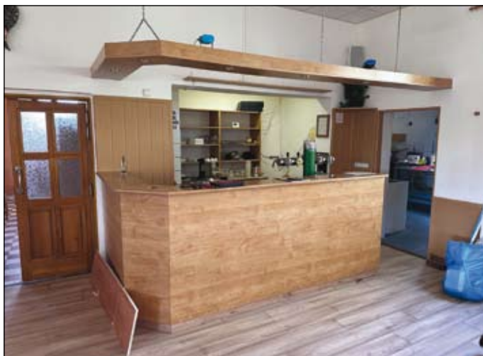
stav rekonstrukce restaurace Na Vrablovci – foceno 4. dubna
