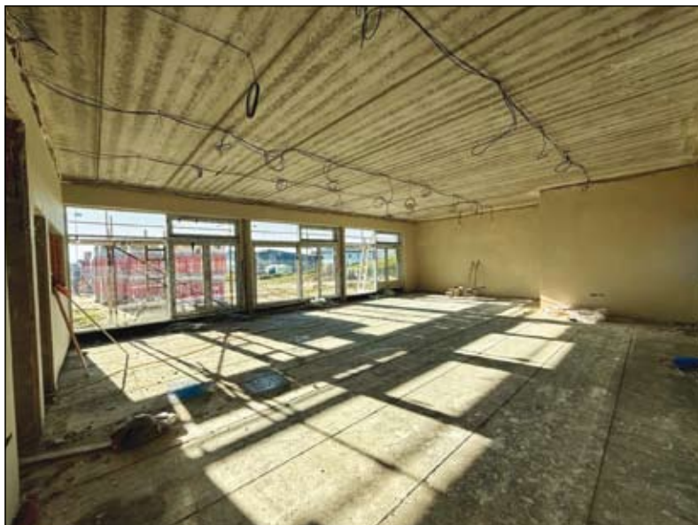
průběh stavby MŠ Rybníky
