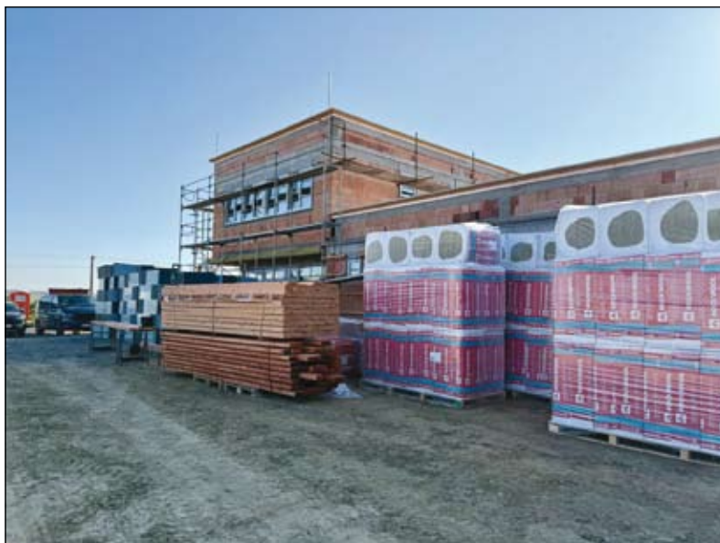
průběh stavby MŠ Rybníky
