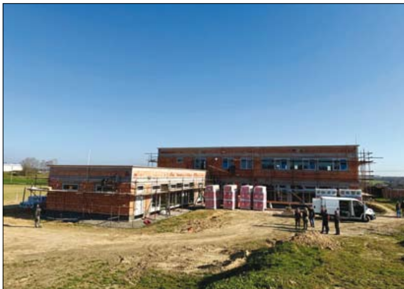
průběh stavby MŠ Rybníky
