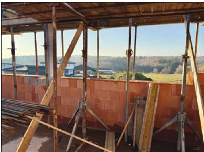
stav stavby nové MŠ Rybníky koncem listopadu
