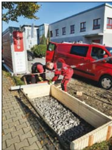
zhotovení základů pro balíkovnu PPL
