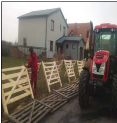
instalace sněhových zábran na Vrablovci
