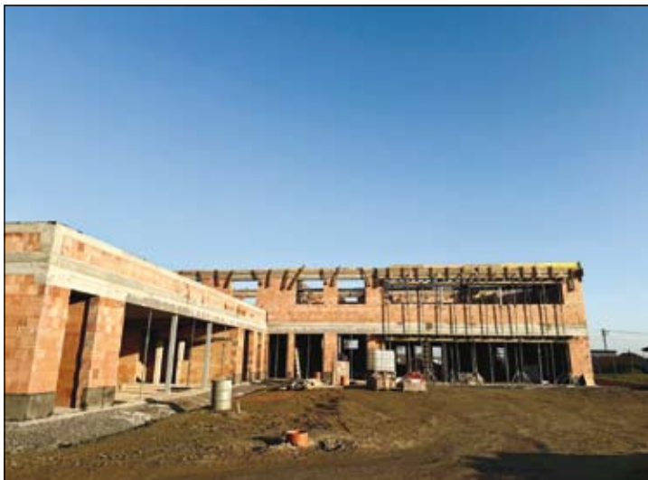
stav stavby nové MŠ Rybníky koncem listopadu
