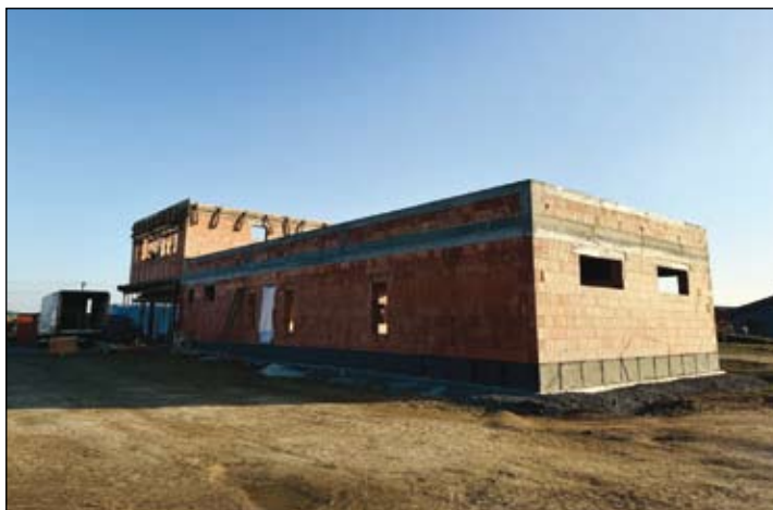
stav stavby nové MŠ Rybníky koncem listopadu
