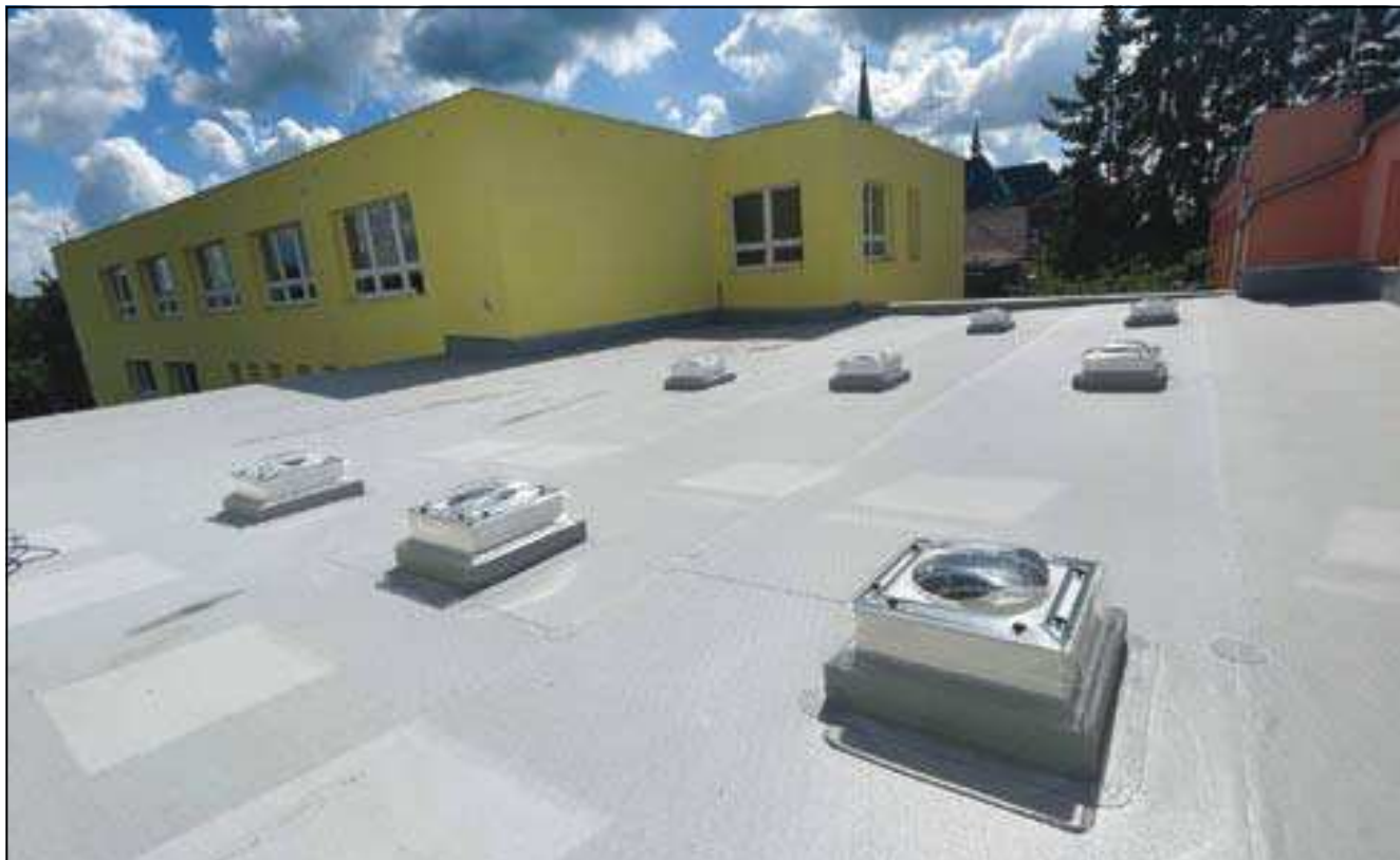
střecha se světlovody
