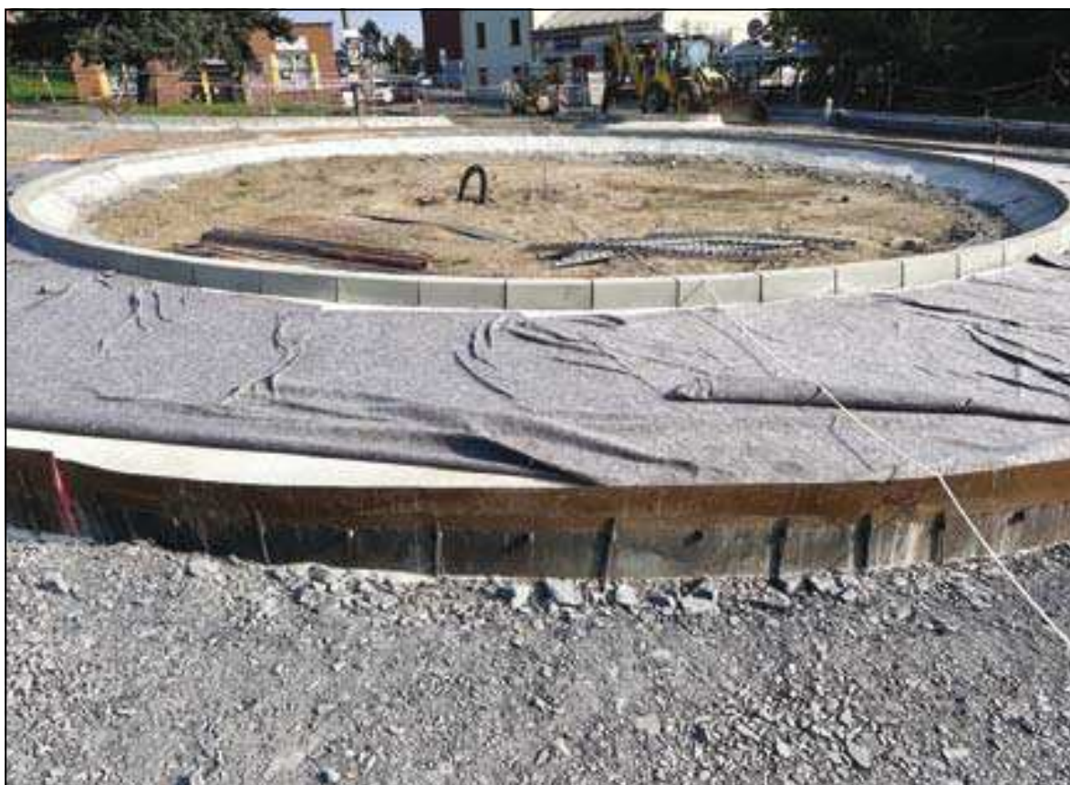
stavba kruhového objezdu – stav k 22. srpnu 2023
