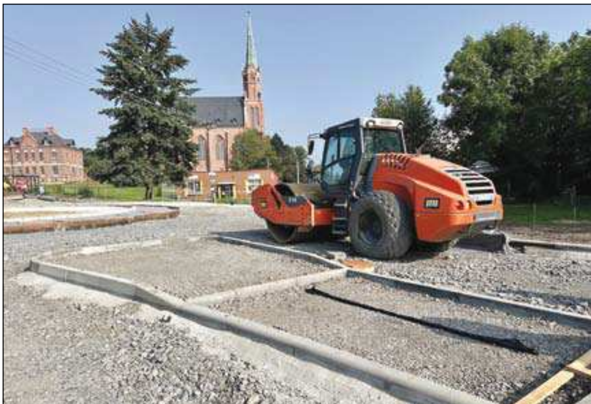
stavba kruhového objezdu – stav k 22. srpnu 2023
