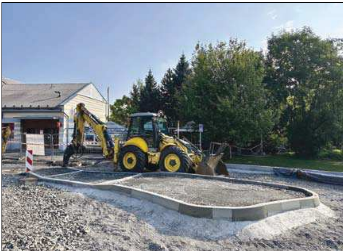
stavba kruhového objezdu – stav k 22. srpnu 2023
