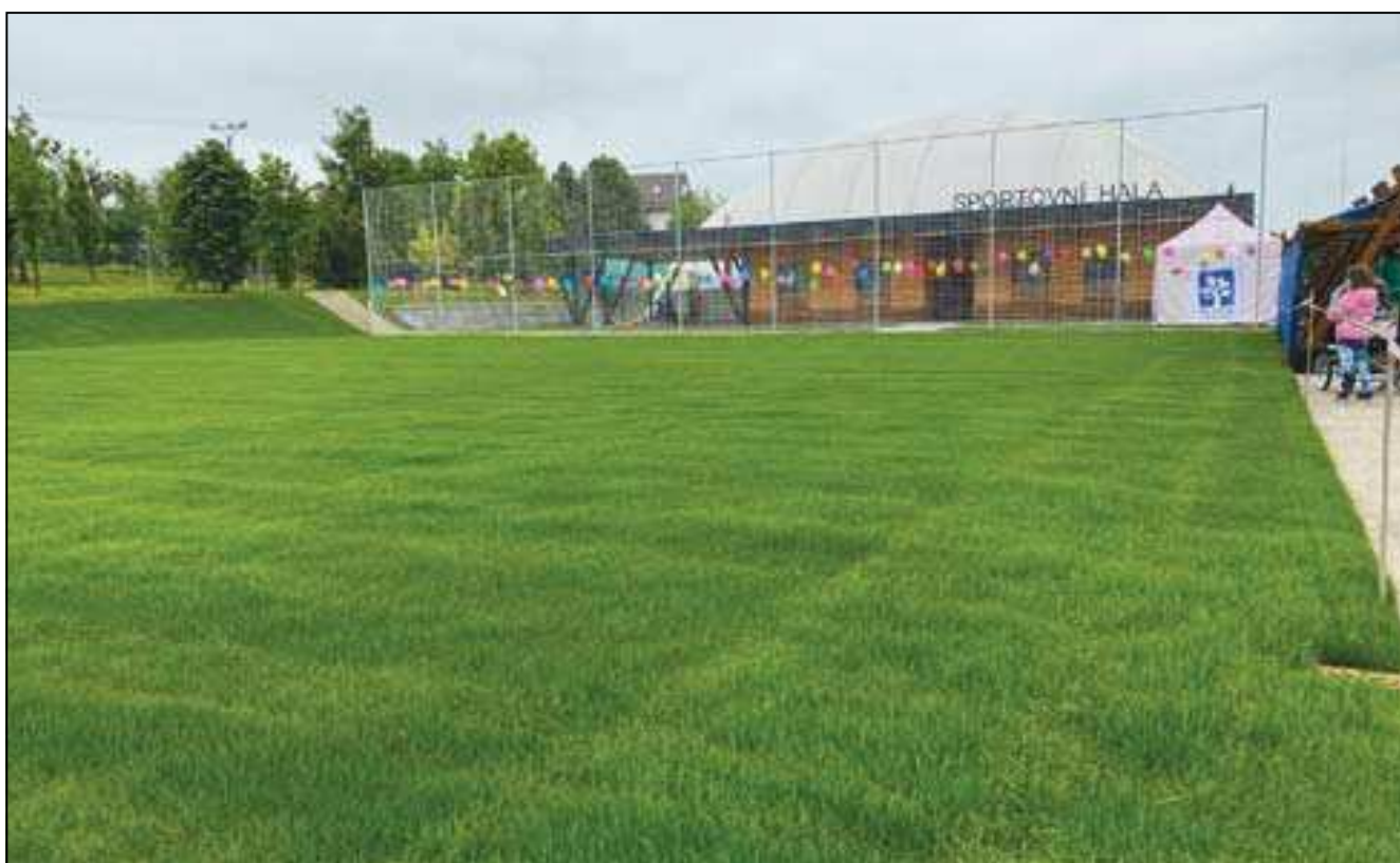
školní hřiště po rekonstrukci
