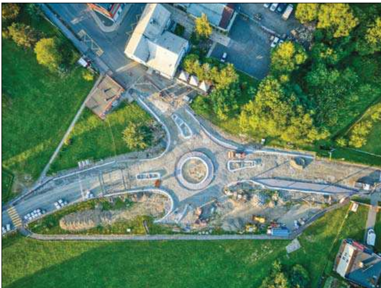
stavba kruhového objezdu 20. srpna 2023 kolem 18:30 hod.
