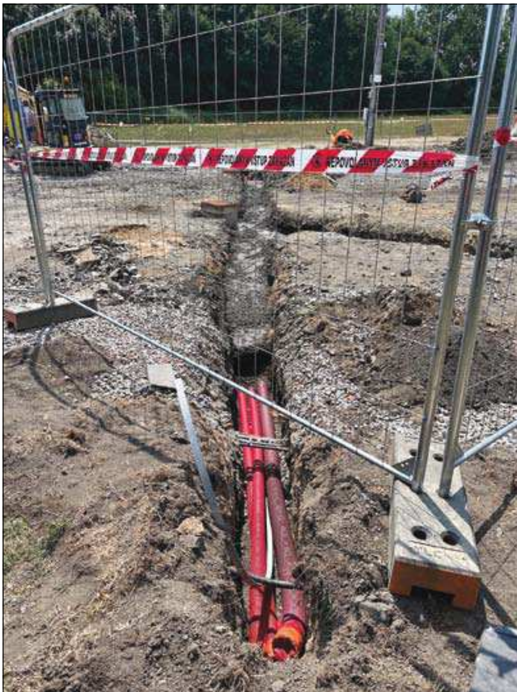
stav prací na kruhovém objezdu k 20. 7. 2023
