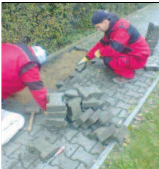
oprava dlažby chodníku
