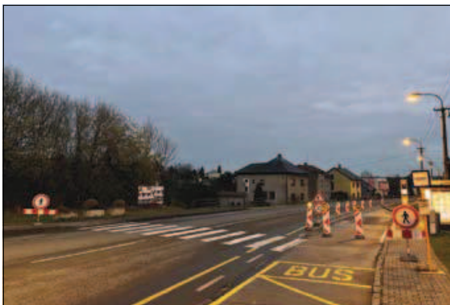
rekonstrukce autobusové zastávky
