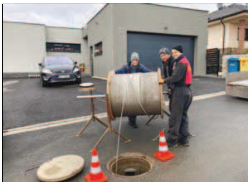
odvíjení chráničky z bubnu a její instalace
