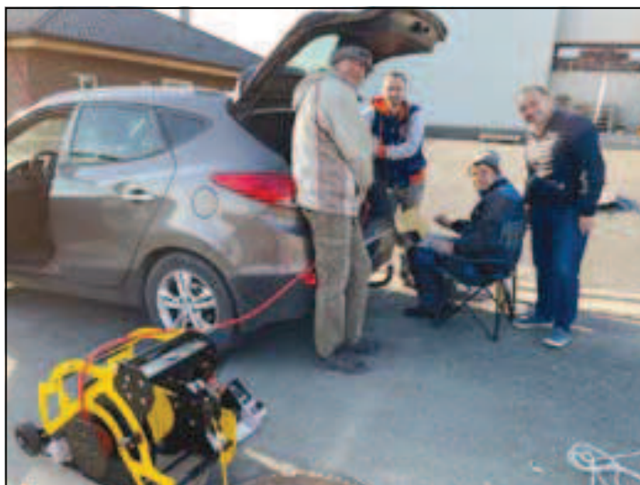
tahání optického kabelu
