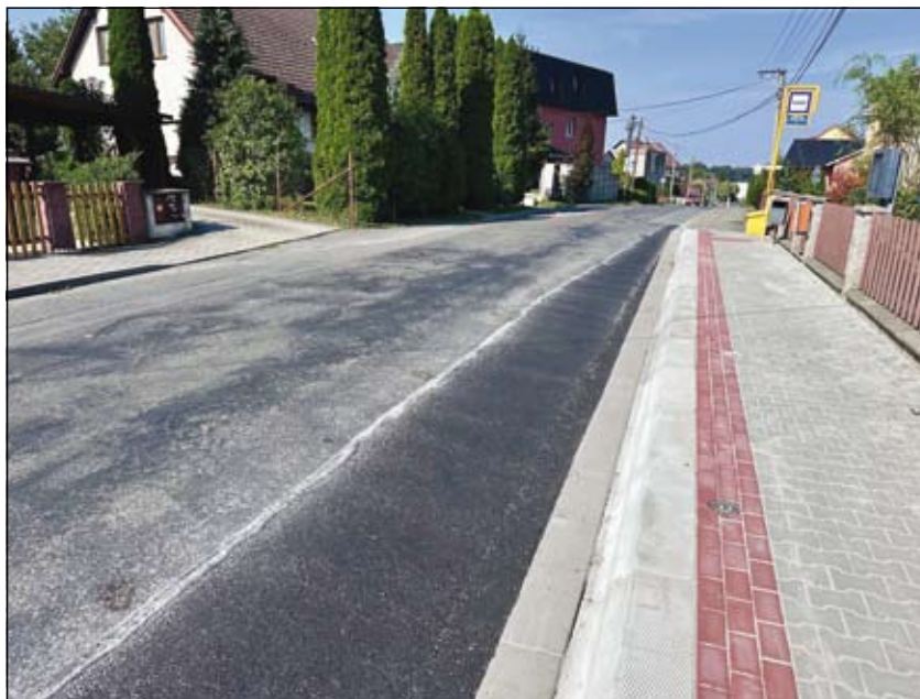
nově opravená zastávka MHD na Vrablovci
