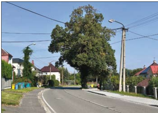
pohled na zrekonstruovaný chodník na pravé straně a na nevyhovující asfaltový na levé straně
