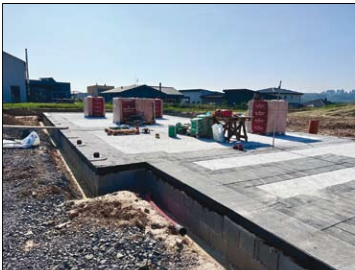
pohled na stavbu MŠ Rybníky, foto z 29. srpna
