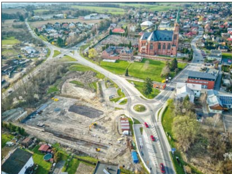
stav stavby Centra služeb a prodejny Hruška k 20. březnu
