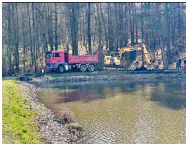
stav v pondělí 4. března – start prací
