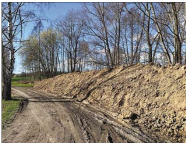
stav k 4. březnu – start prací
