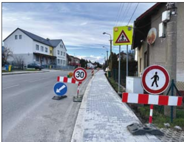
oprava chodníku na Hlučinské ulici
