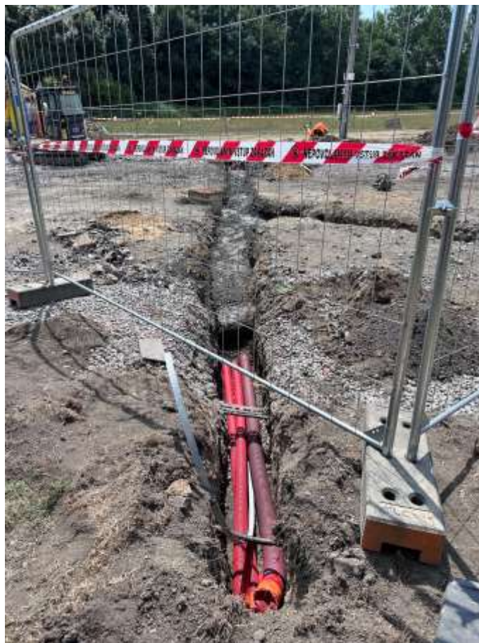
stav prací na kruhovém objezdu k 20. 7. 2023.
