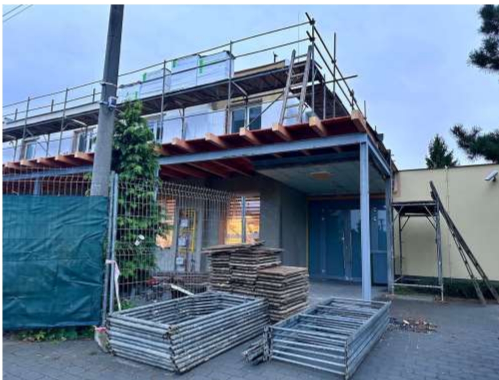
stav opravy vstupu do restaurace a Obecního domu
