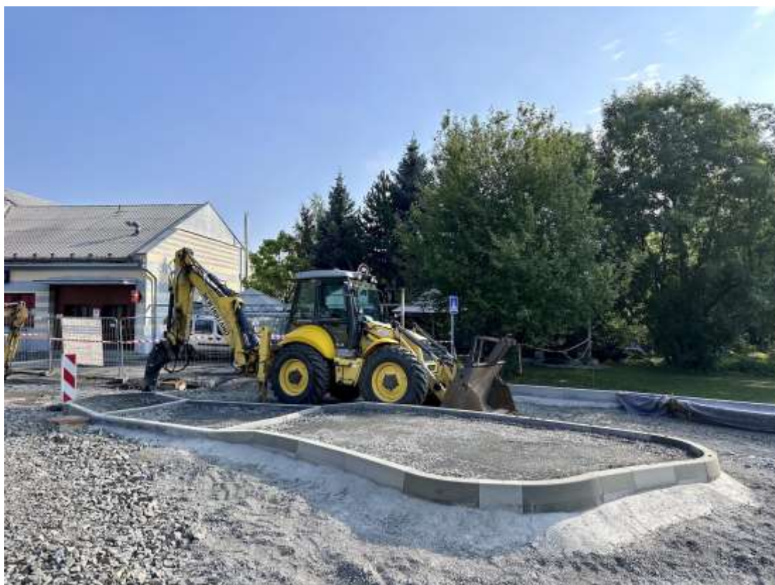
stavba kruhového objezdu - stav k 22. srpnu 2023
