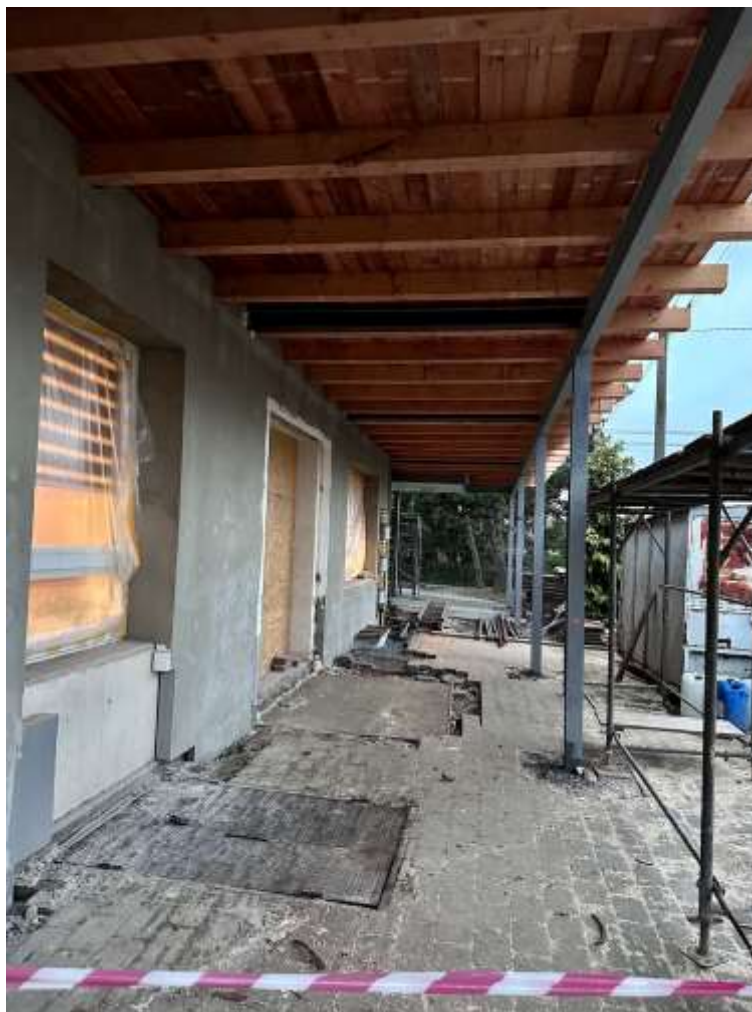
stav opravy vstupu do restaurace a Obecního domu
