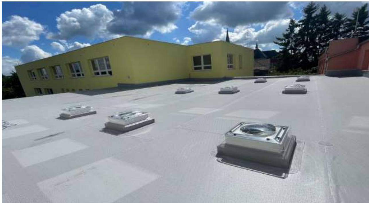
střecha se světlovody
