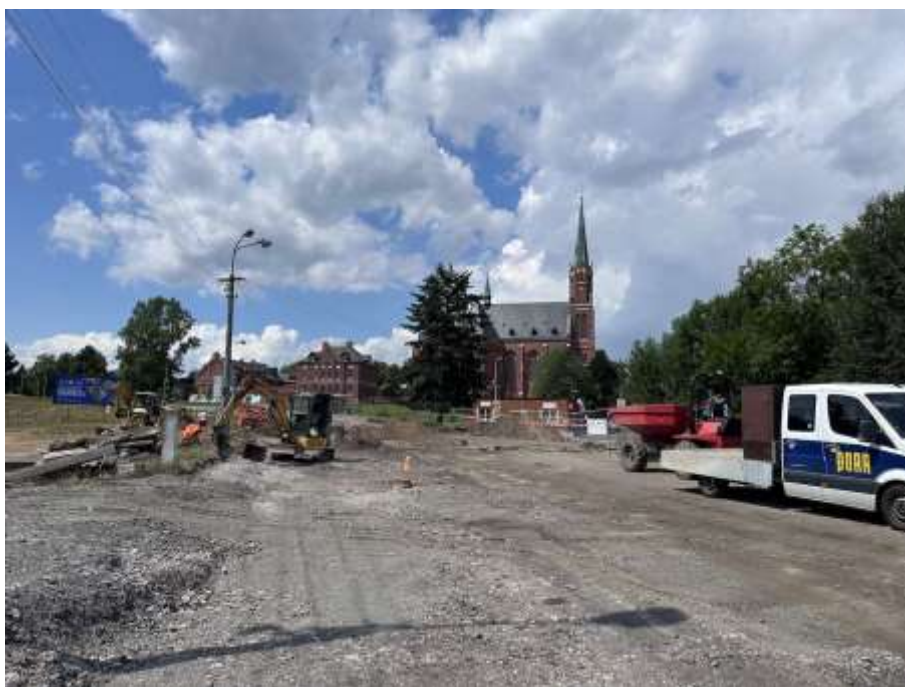
stav prací na kruhovém objezdu k 20. 7. 2023
