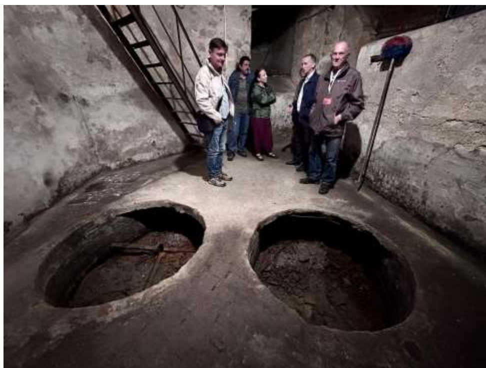
sklepení kostela (bývalá kotelna)
