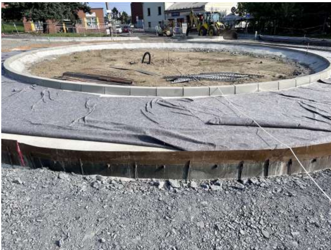
stavba kruhového objezdu - stav k 22. srpnu 2023
