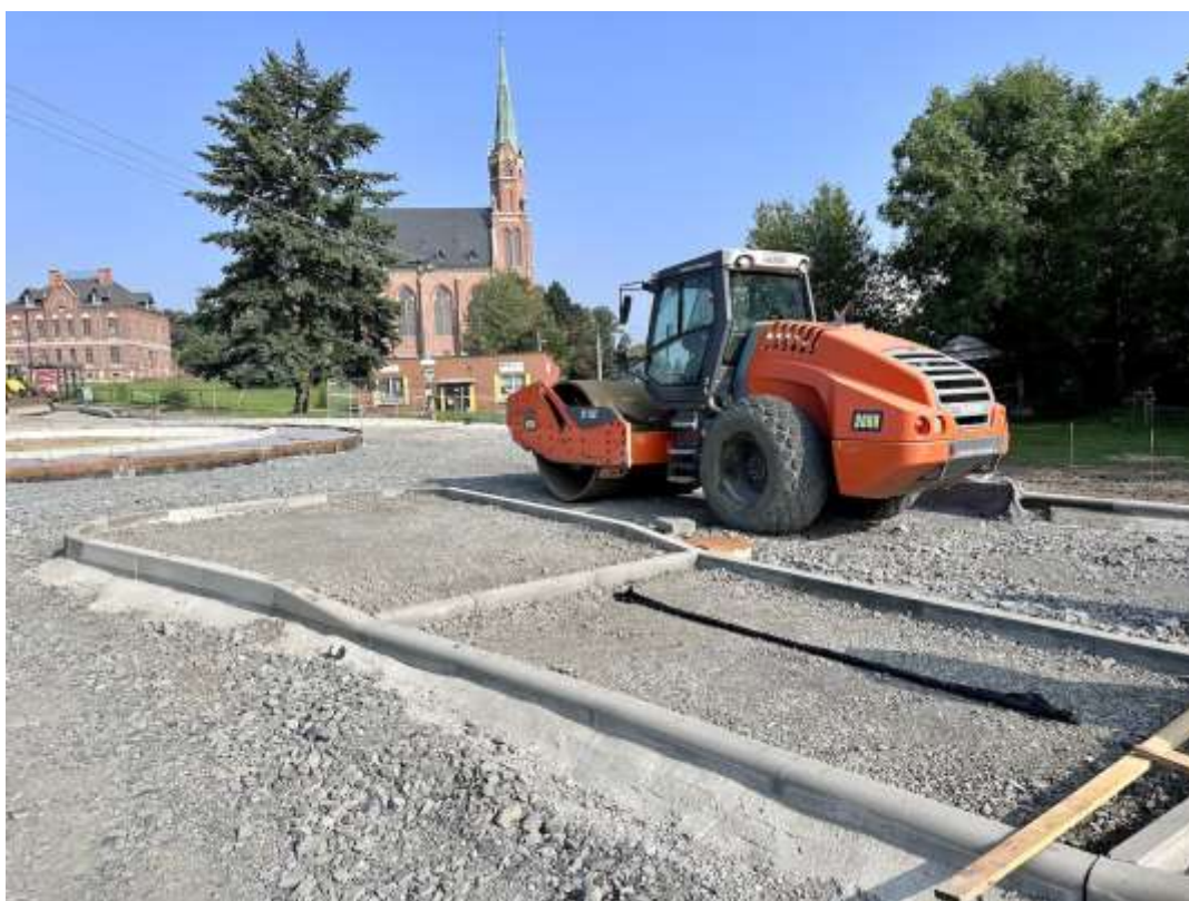
stavba kruhového objezdu - stav k 22. srpnu 2023
