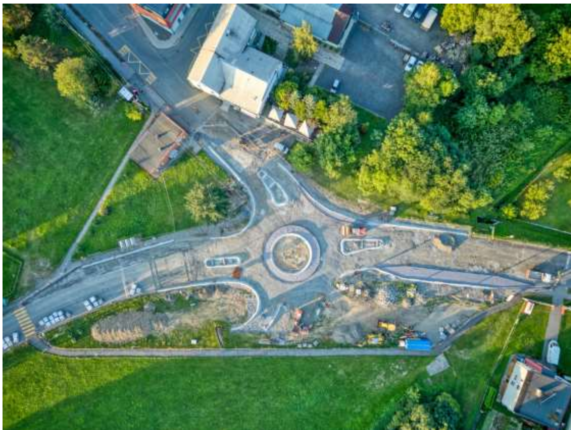
stavba kruhového objezdu 20. srpna 2023 kolem 18:30 hod.
