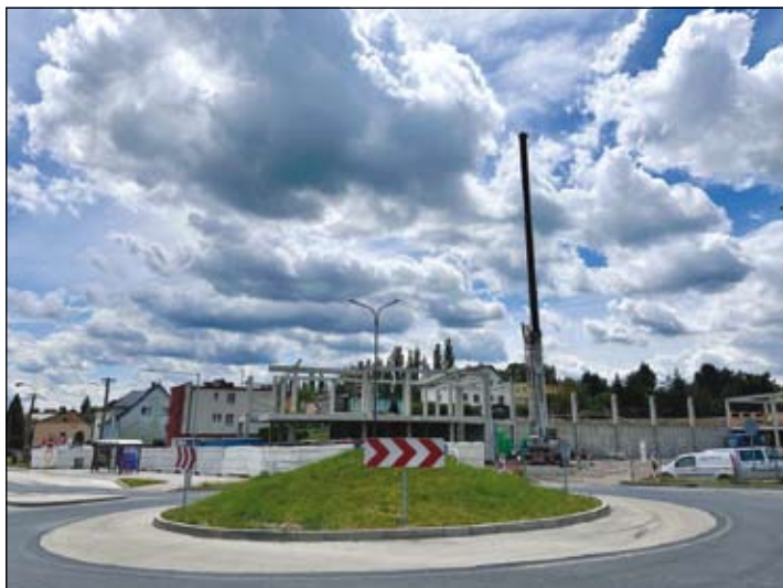
Centrum služeb a obchod Hruška – stav k 23. květnu
