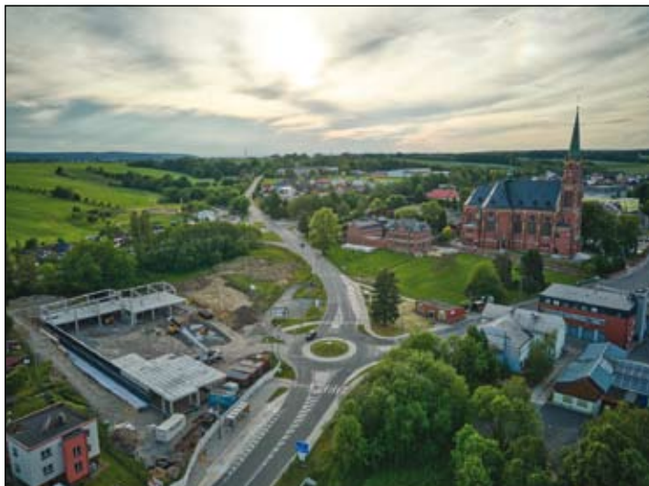
Centrum služeb a obchod Hruška – stav k 22. květnu
