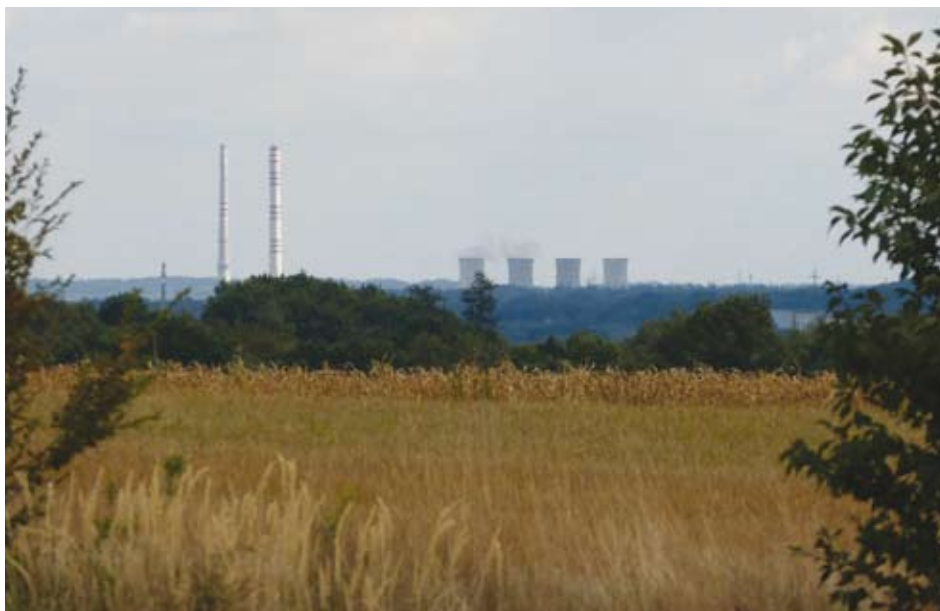
výhled na elektrárnu Dětmarovice
